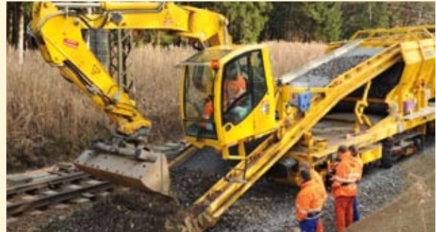
Wiebe Schottertausch mit Planumsverbesserung Gleislos
